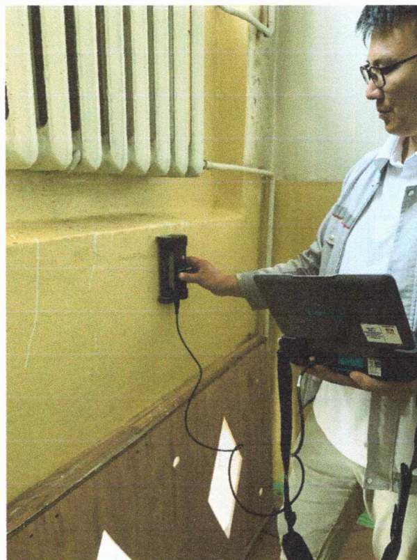
Зураг 20. Төмөрбетон бүс шалгаж буй байдал.
