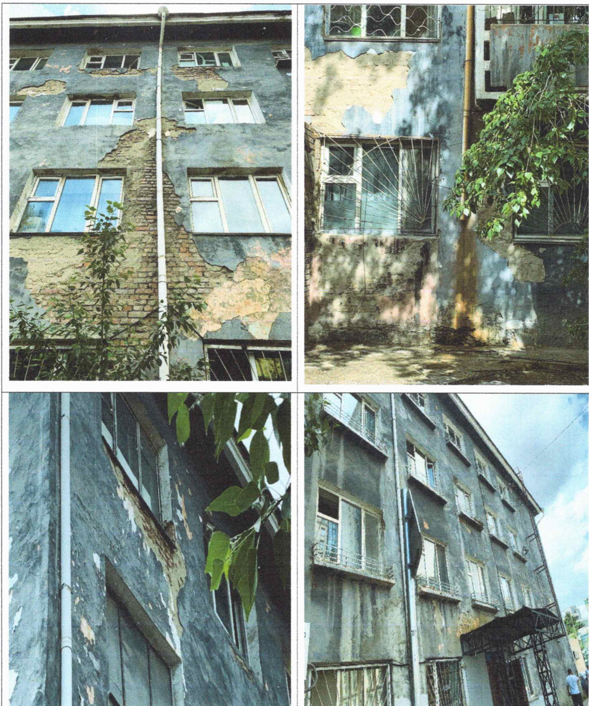
Зураг 33-41. Дээврийн хучлагын битүүмжлэл алдагдсан, ус зайлуулах цорго хоолой эвдрэл үүссэнээс хурын ус барилгын гадна ханыг даган урсаж, өнгөн шавардлага хөндийрөн ховхорч улмаар тоосгон өрөг байгаль цаг агаарын хүчин зүйлийн үйлчлэл, хүний үйл ажиллагааны үр дүнгээр бүтээц, элементийн анхны техник-эдэлгээний чанар буурахад нөлөөлжээ.
